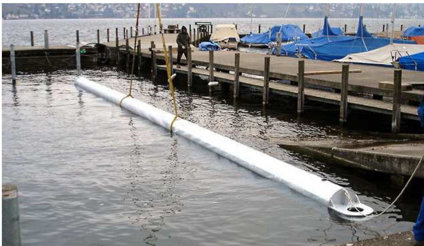
Das Verankerungsrohr schwimmt im Hafenbecken, bevor es geflutet wird.
